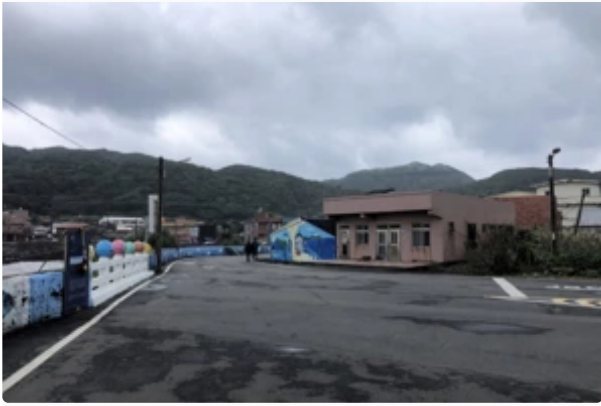
貢寮卯澳漁港要道橋樑封閉改建 明起改走北部濱海公路
